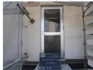
屋上出入口シーリング 打替え後
