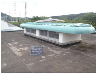
ウレタン防水施工前
