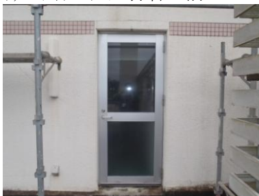
屋上出入口シーリング 打替え前
