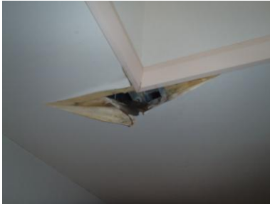
ビニールクロス張替前
