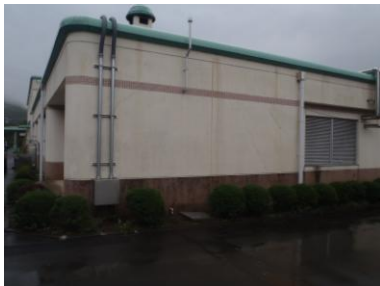
外壁クラック処理前
