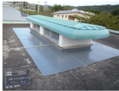
ウレタン防水施工後
