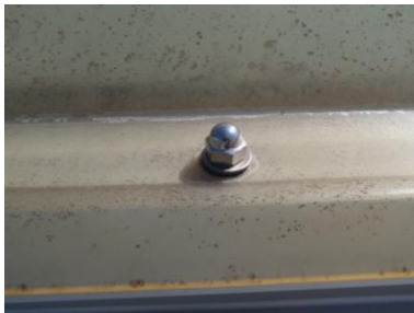
トップライトシーリング 打替え前
