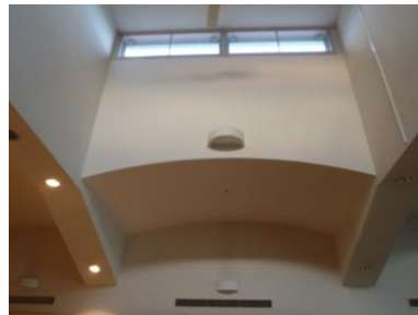
ビニールクロス張替後
