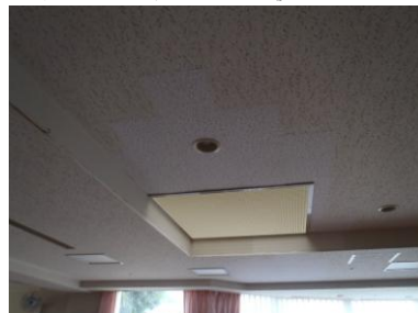
天井岩面吸音板張替後
