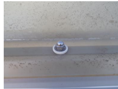
トップライトシーリング 打替え前
