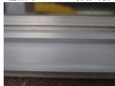
中庭サッシ水切り目地シーリング 打替え後
