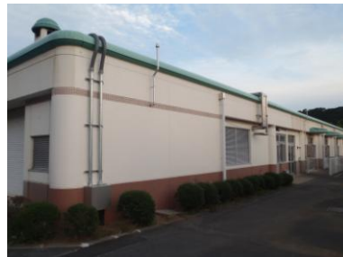
外壁クラック処理後
