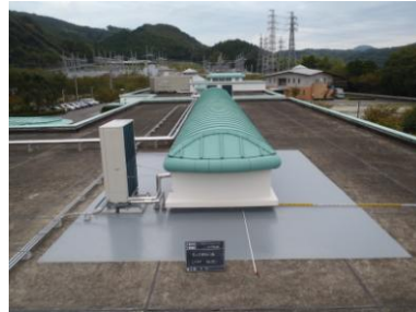
ウレタン防水施工後
