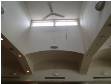
ビニールクロス張替前
