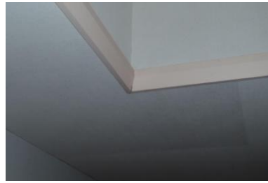
ビニールクロス張替後
