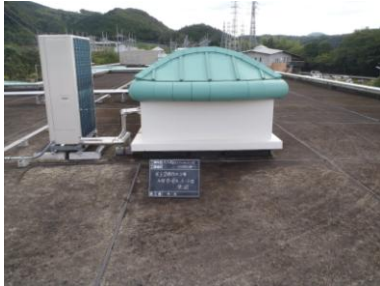
ウレタン防水施工前
