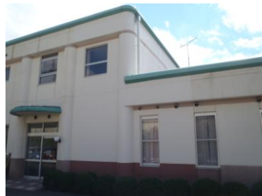
外壁クラック処理後
