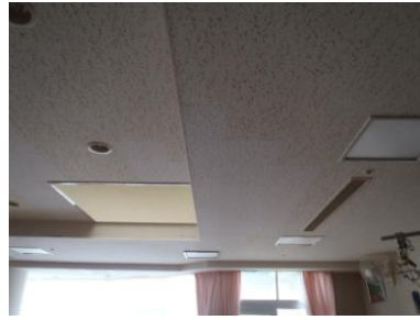
天井岩面吸音板張替後
